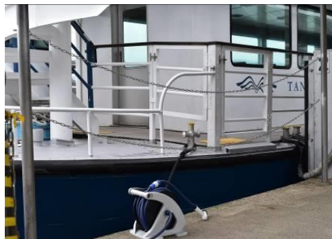
○一の宮栈橋海中転落防止チェーンの設置
